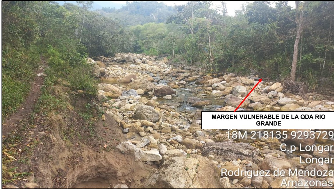
FIGURA N°02: TRAMO EXPUESTOS A EROSION Y SOCAVACION ANTE UNA CRECIDA DE LA QUEBRADA RIO GRANDE EN LA MARGEN IZQUIERDA
